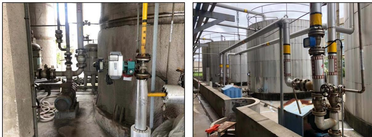
图 4.2.3 原辅料输送管道照片
